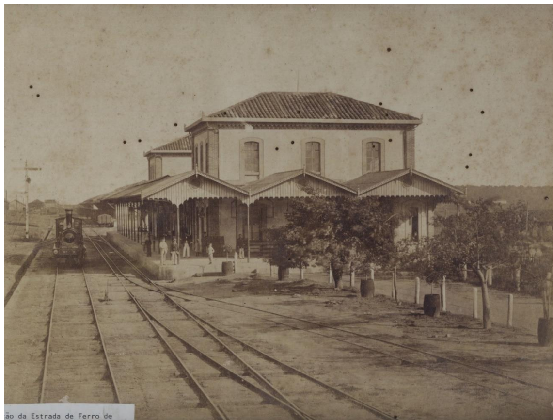
Figura 6 – Primeira Estação de Campinas.
