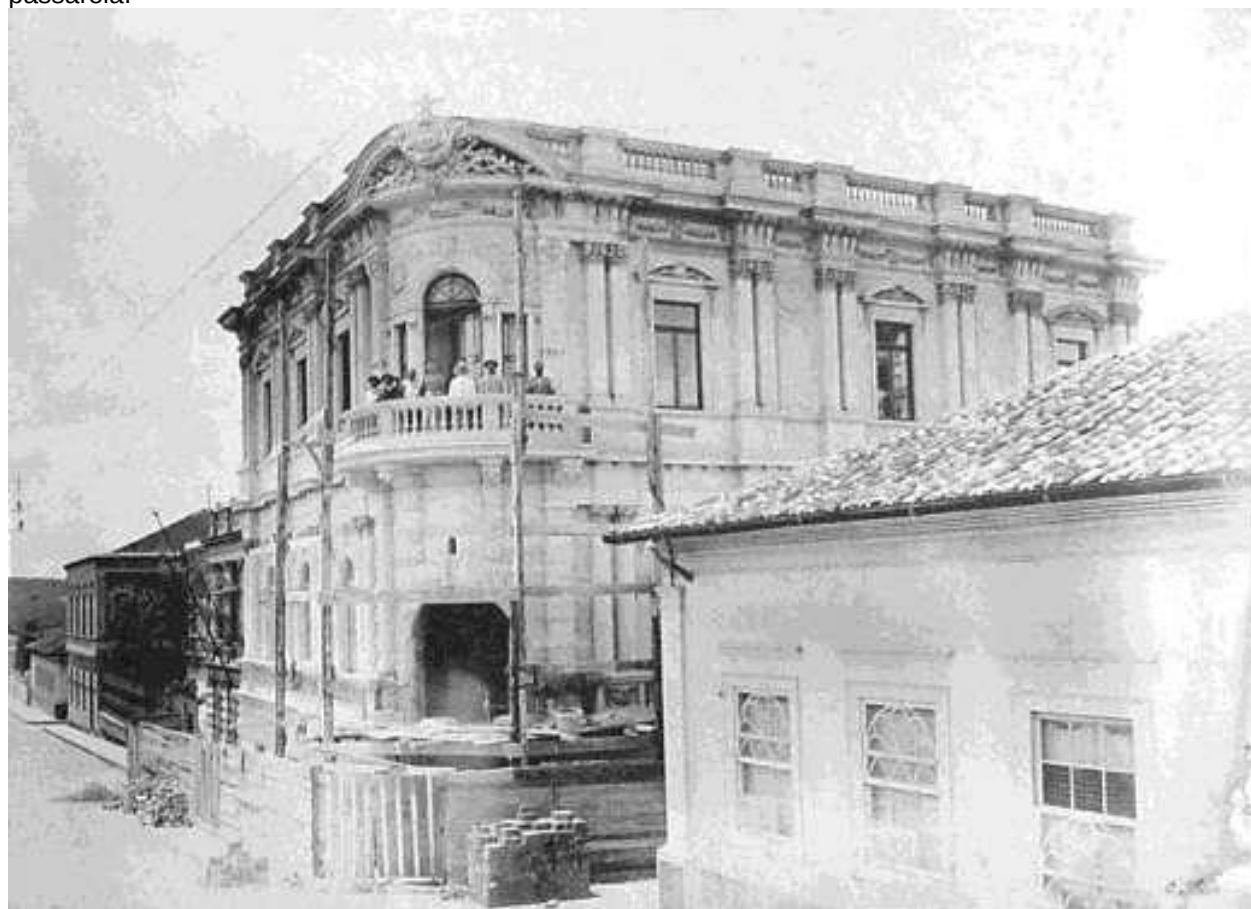
Figura 25 – Escritório Central da Companhia Mogiana, Pavilhão Campos Sales em construção 54 .
