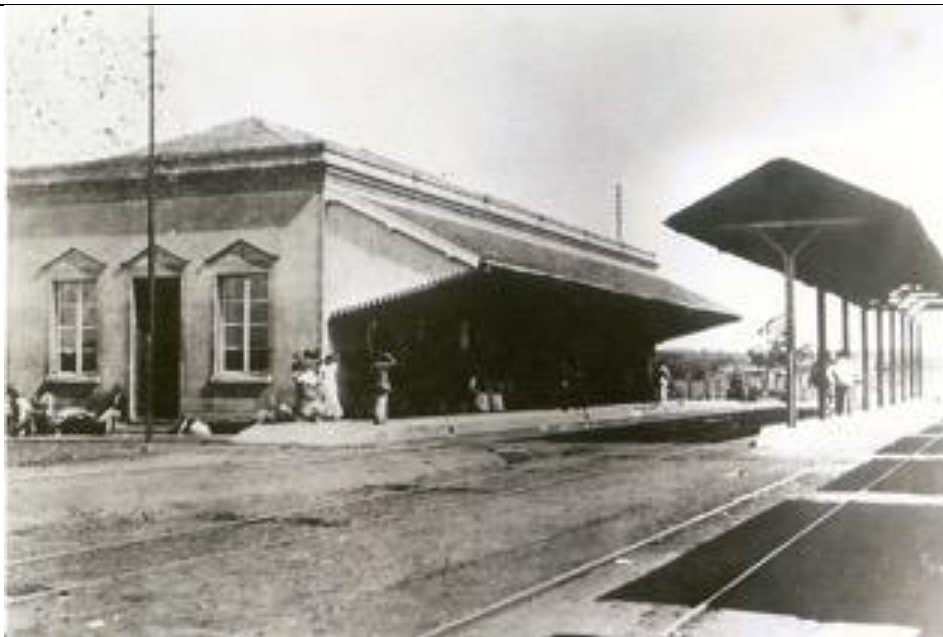
Figura 15 – Estação Guanabara. Campinas. 1893 39 .
