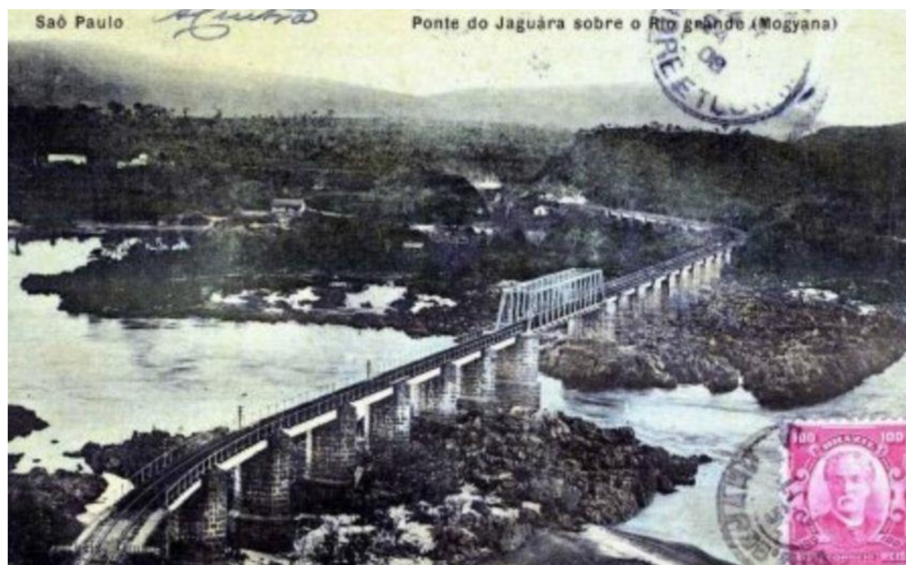
Figura 12 – Viaduto do Jaguará sobre o Rio Grande na Divisa São Paulo/Minas Gerais 26 .
